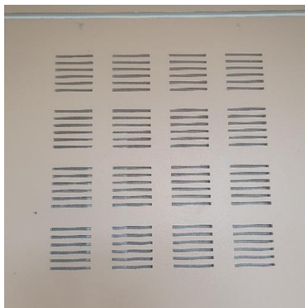
Figure 5 : Traitement acoustique mural des salles à manger à base de plâtre perforé associé à un isolant
