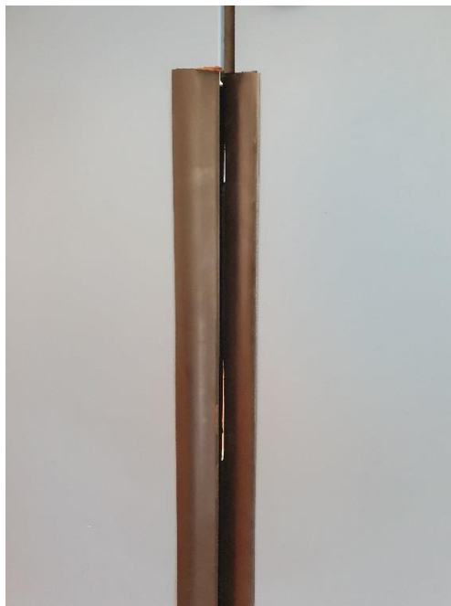
Figure 15 : Jour au niveau de l'anti-pince-doigt du bloc-porte de la salle de sieste PS dû à un défaut de compression
