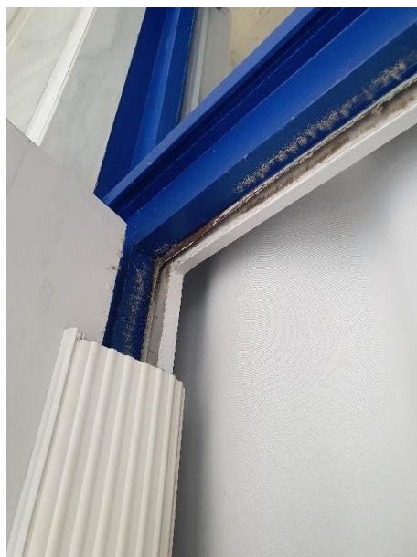
Figure 13 : Joints périphériques existants
